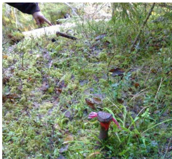
Bolter står igjen fra damfestet oppe på Magaberget.
