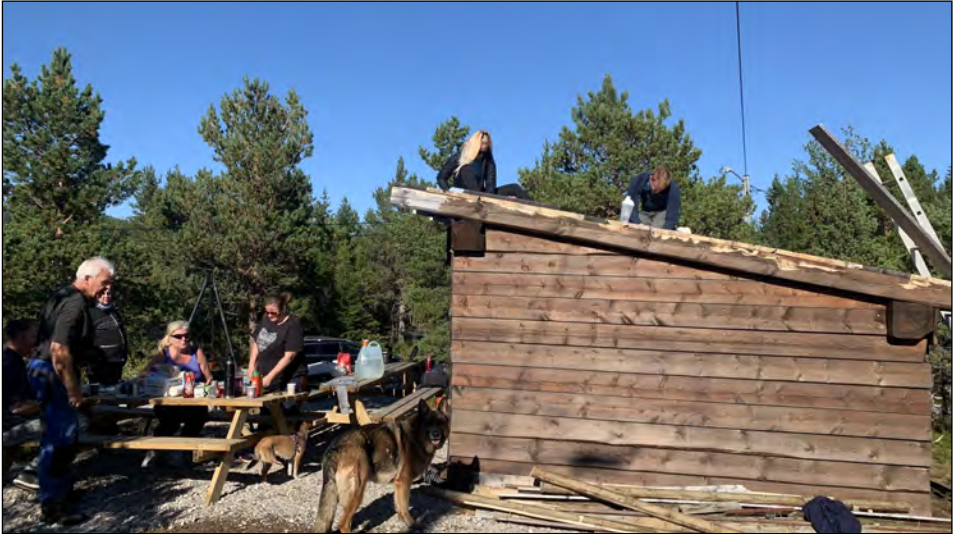
Kjella IL har dugnad. Det legges nytt tak på gapahuken i lysløypa.
