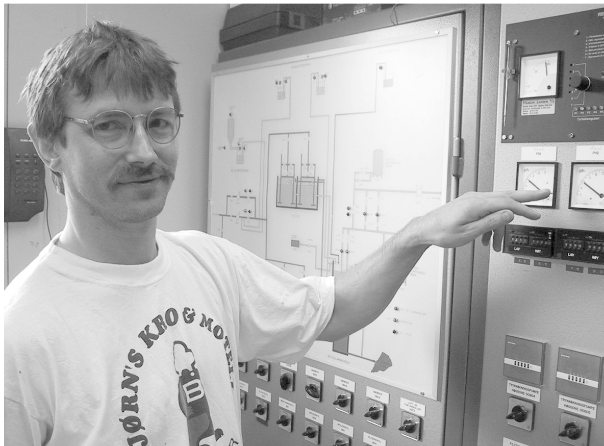
Jan Børre Bruvold er driftsoperatør på Terråk vannverk i sommer. Her leser han av pH-verdi for drikkevannet.
