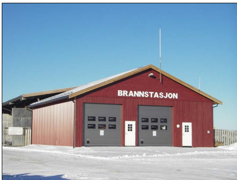
Brannstasjonen på Terråk ble tatt i bruk i 2009.
