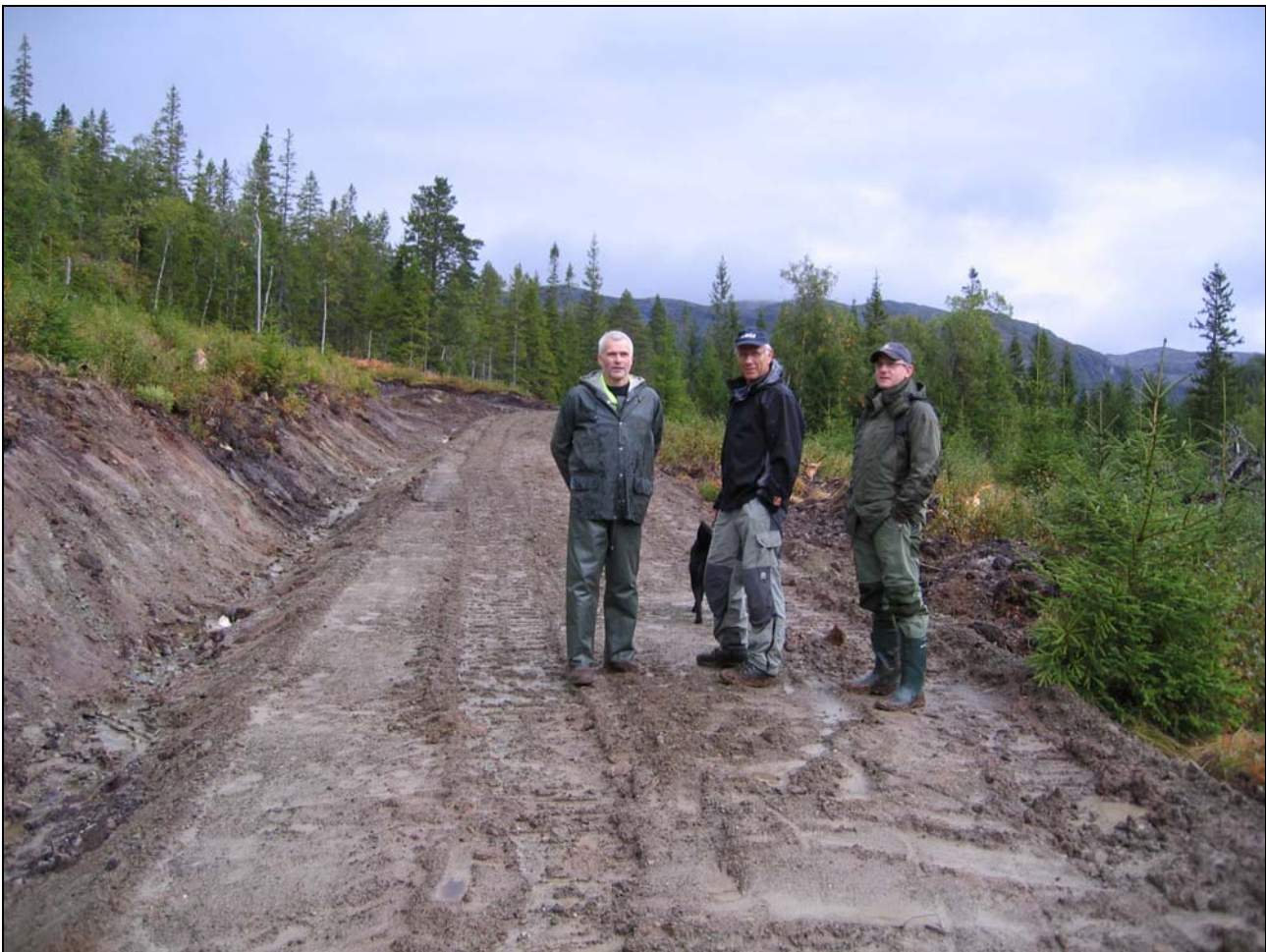
Veibefaring på Storåveien.
