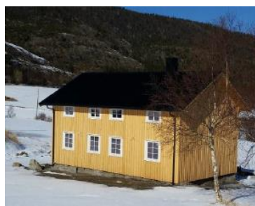
Etter skifting av tak, vinduer og bordkledning
