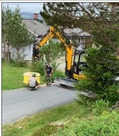
Det graves i boligfeltene på Terråk, slik at det kan legges fiberkabel fra Telenor.
