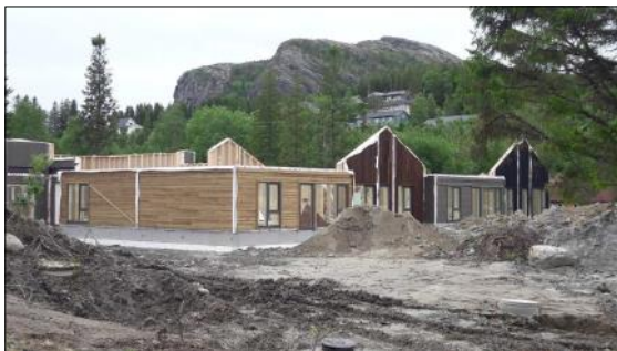
Omsorgsboligene bygges i området mellom barnehagen, skolen og Coop Marked på Bindalseidet.
