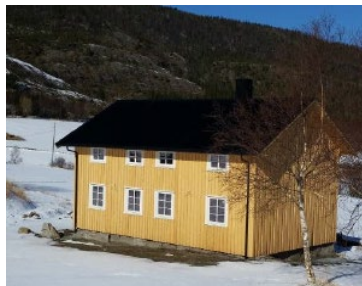
Etter skifting av tak, vinduer og bordkledning
