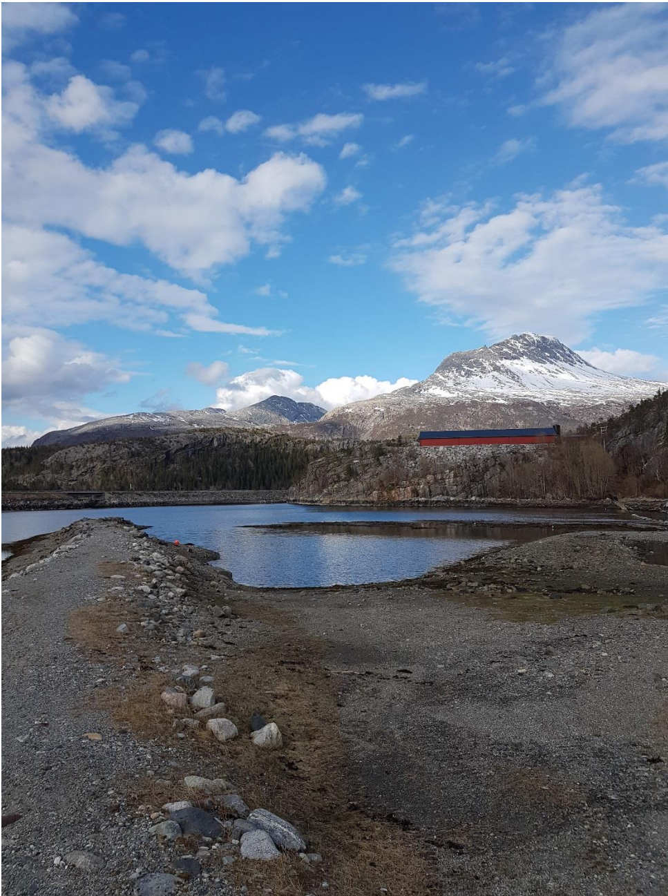
Figur A-3. Bildet viser moloen i sørenden av bukta. En bygning tilhørende settefiskanlegget kan skimtes i bakgrunnen. Foto: Aqua Kompetanse AS
