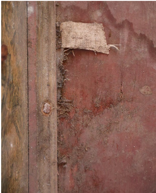
Fig. 15. Rester etter lerret langs klemlisten på innsiden av midtfeltet. Enkelte av lerretsbitene har rester etter bemaling, hvilke tyder på at feltet har vært dekket med et lerretsmaleri på et tidspunkt.
