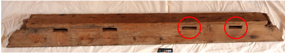
Fig. 14. Tappehull på gesimsene som samsvarer med tappene på sidefeltene.
